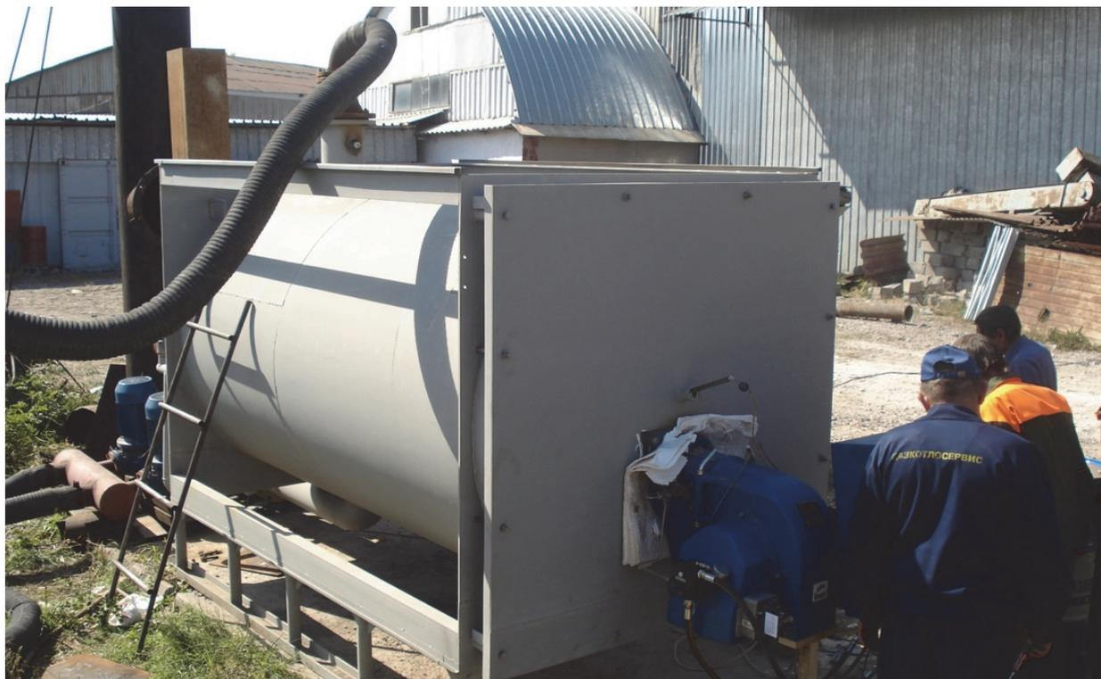
Рисунок 2 - Общий вид котла водогрейного КВа-1,0
