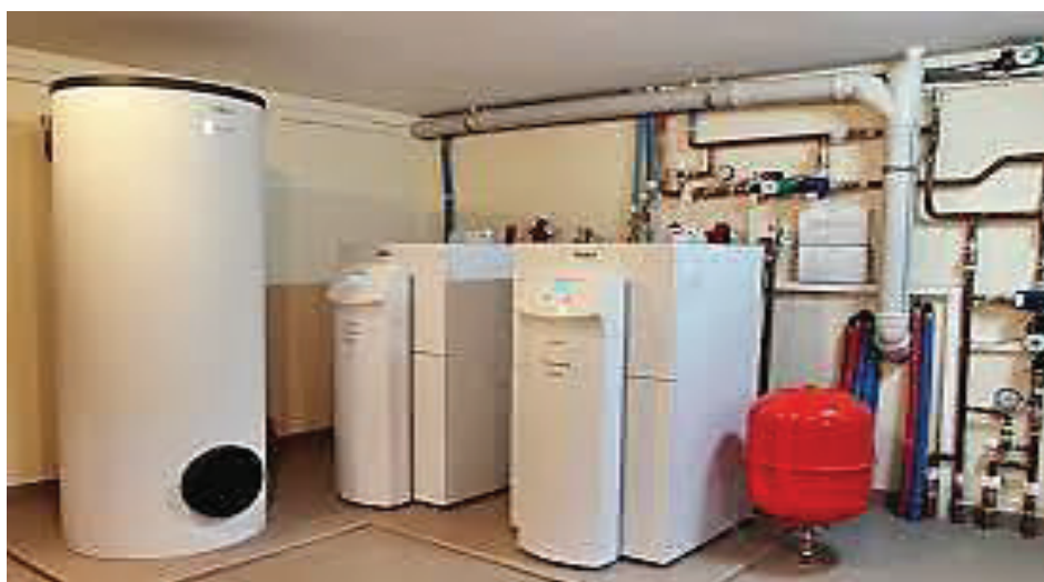
Рисунок 8 - Теплонасосная система теплоснабжения на основе высокотемпературных ТН
