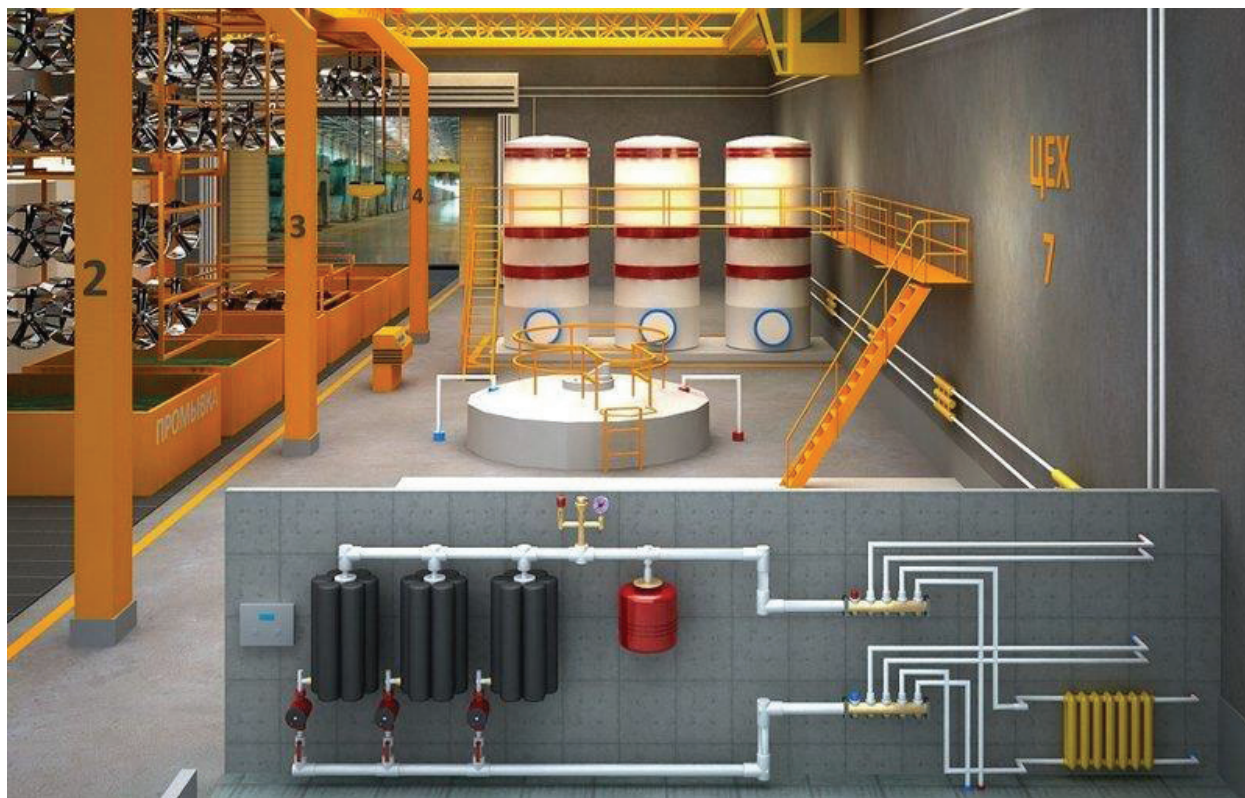
Рисунок 1 - Отопление заводов, складов, офисных зданий геотермальным тепловым насосом Waterkotte
