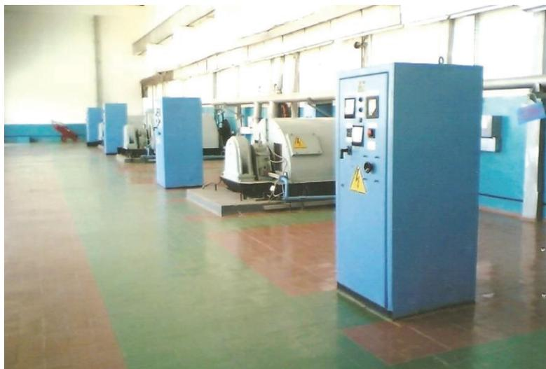
Рисунок 2 - Машинный зал магистральной станции с электродвигателями СТД
