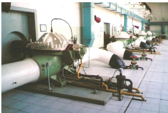
Рисунок 1 - Общий вид насосных агрегатов НМ-2500-230 и НМ-3600-230
