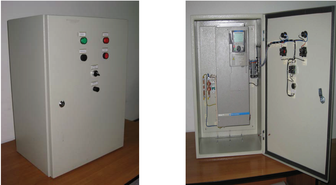
Рисунок 4 - Общий вид шкафа управления электроприводом ПЦЭН, изготовленного авторами
