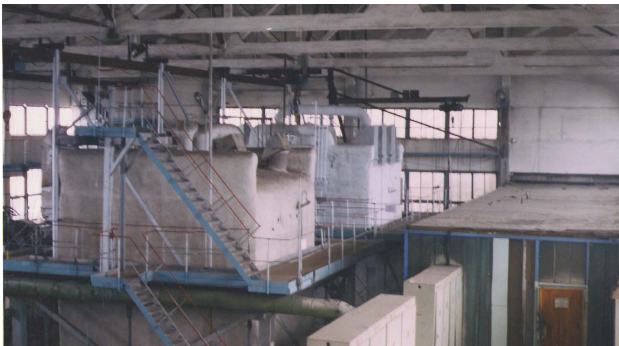
Рисунок 1 – Котел КВ-ГМ-42 (на втором плане)
