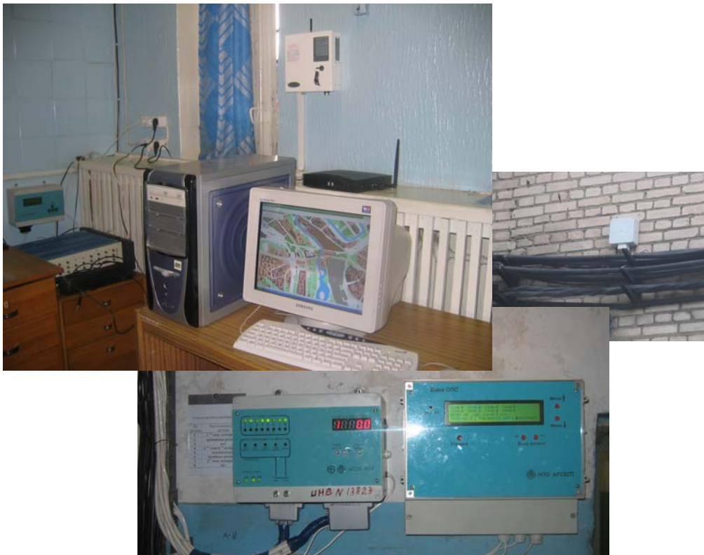
Рисунок 2 - Состав аппаратных средств системы: объектовый компьютер со средствами передачи данных; устанавливаемые в цеху и вне помещений датчики и оборудование
