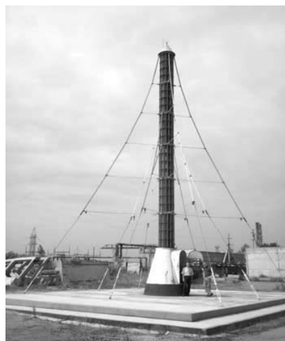
Рисунок 6 – Вертикально-осевая ветровая турбина: 6 модулей, мощность, 15 кВт
