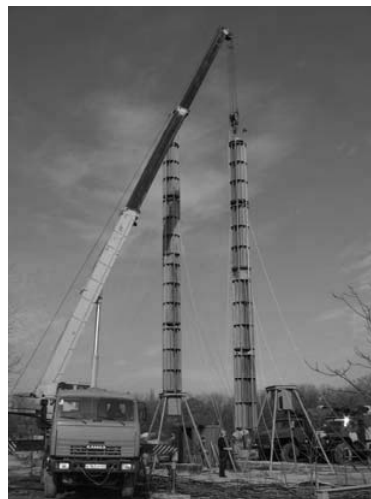
Рисунок 7 – Монтаж ветровых турбин
